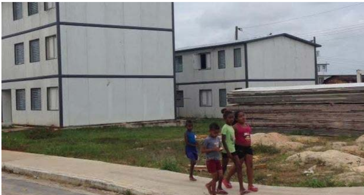
El barrio El Molino, en el Cotorro, formado por 19 edificios de 'petrocasas'. (14ymedio)
