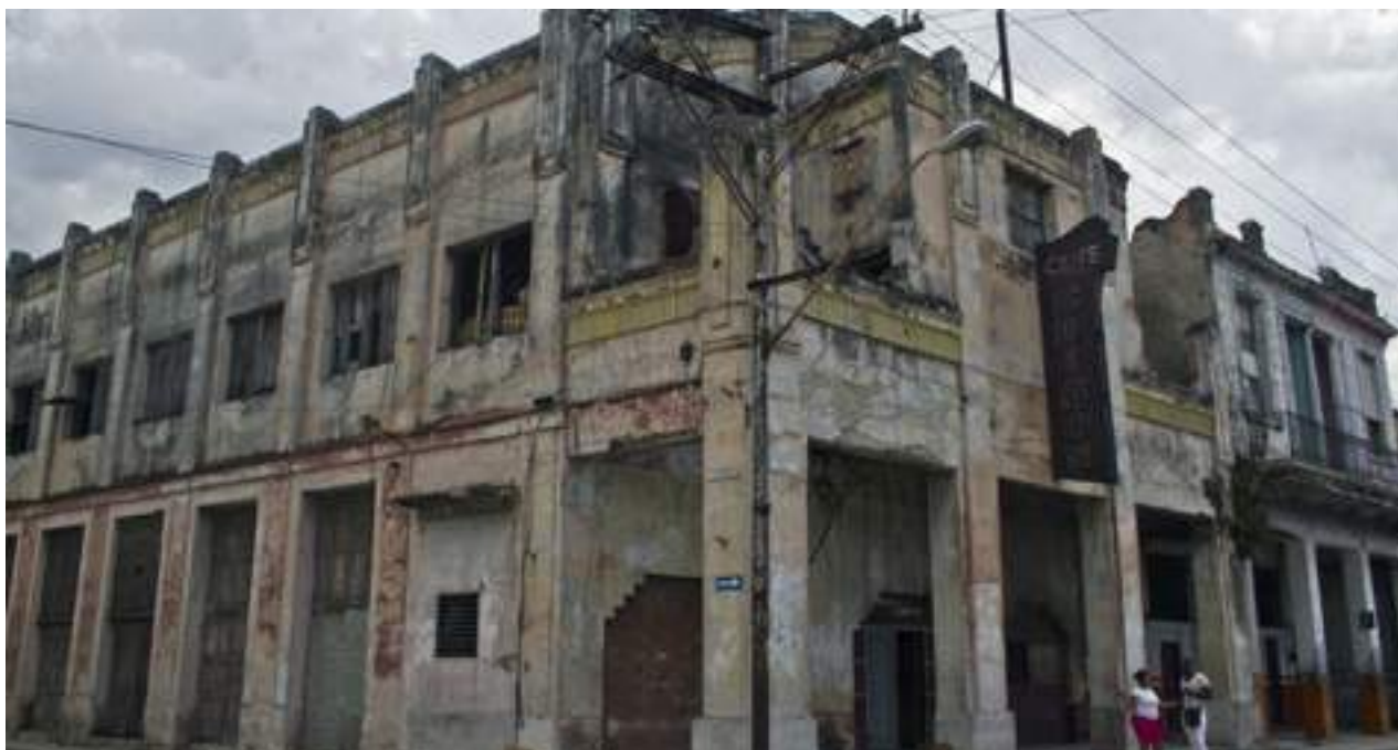
Cine Edison, reconvertido en vivienda y con peligro de derrumbe. (14ymedio)
