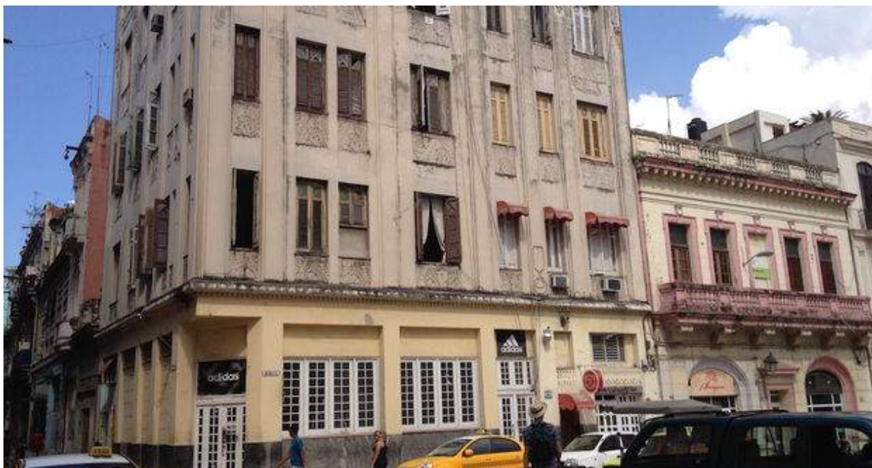
Los vecinos de la calle Bernaza #2, entre Obispo y O'Reilly, fueron víctimas de un accidente provocado por la Empresa Eléctrica. (14ymedio)
