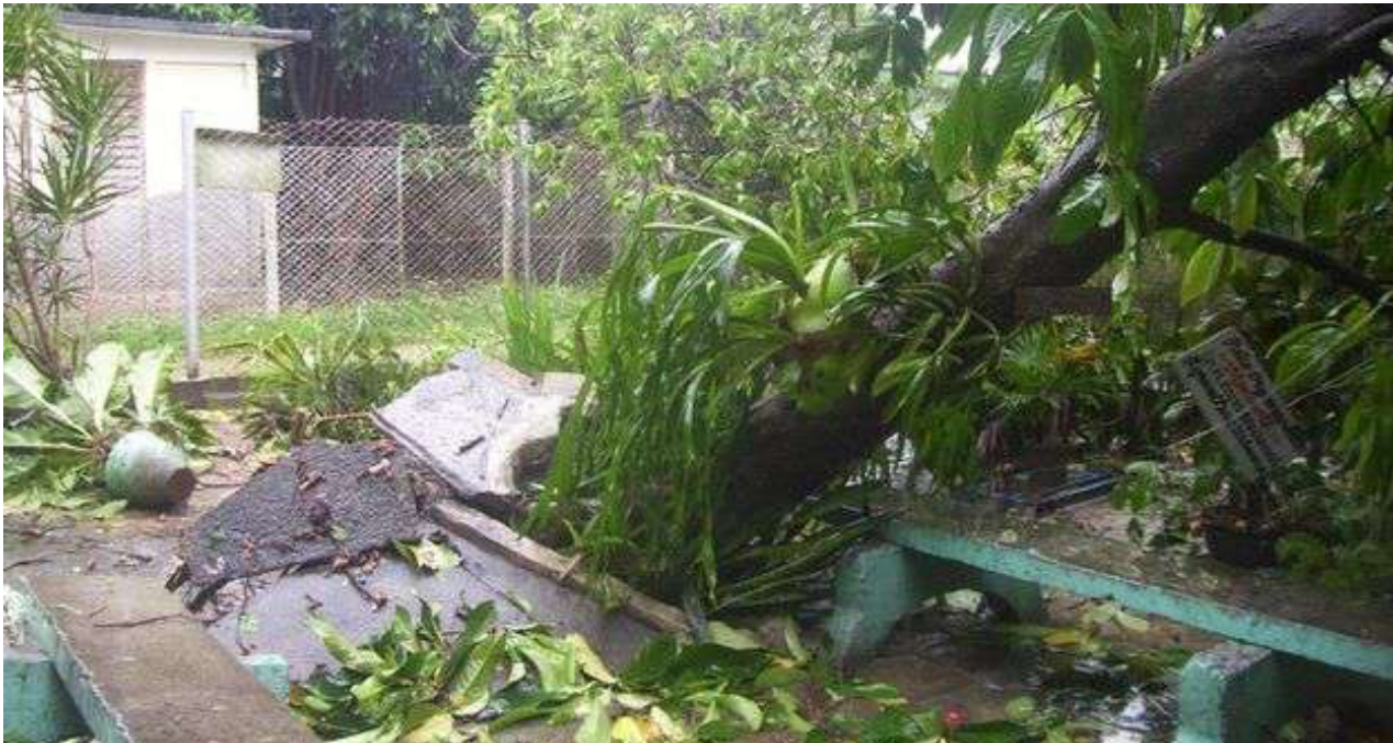
El huracán Michael provocó daños visibles en la provincia de Pinar del Río. (Radio Sandino)
