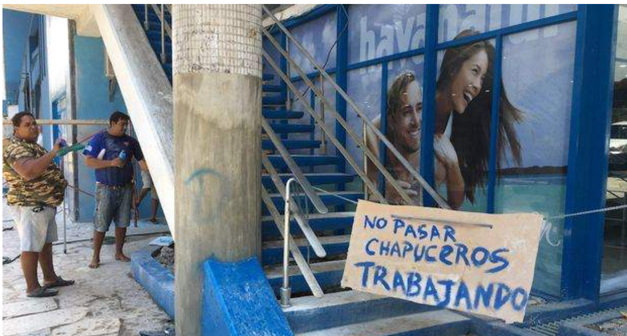
Cartel junto a las obras en los bajos del hotel Habana Libre. (14ymedio)
