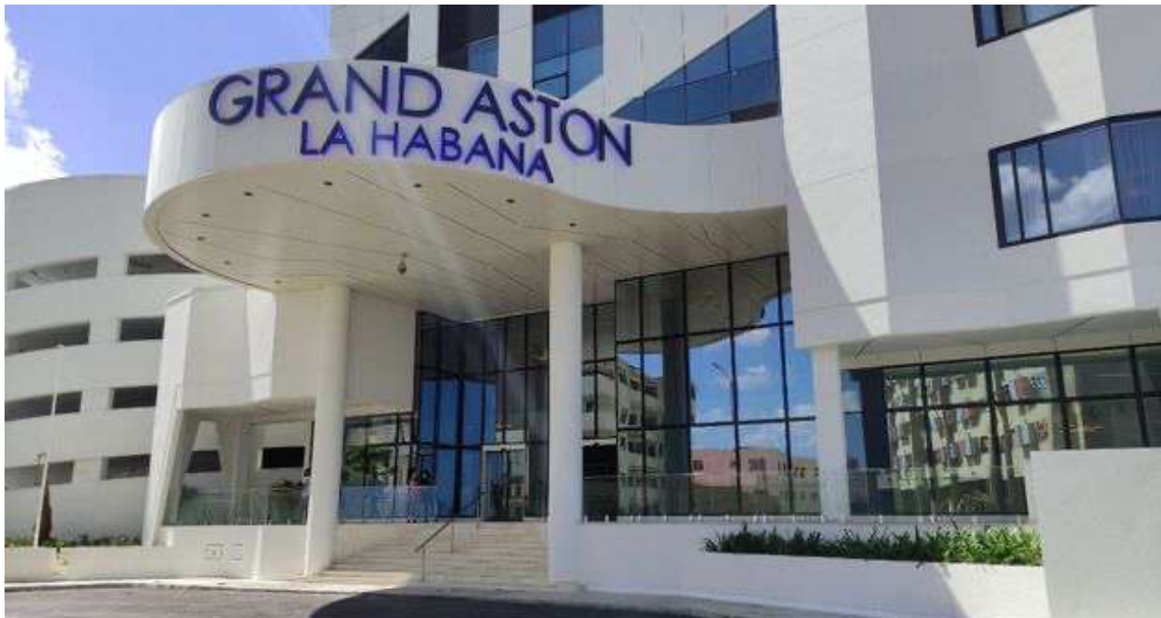
Hotel Grand Aston La Habana, recién construido por Gaesa en el Malecón. (14ymedio)
