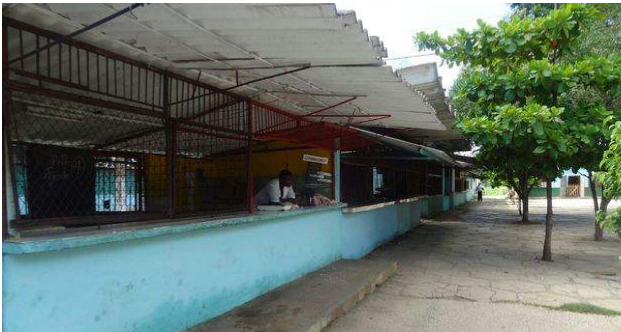
El área dedicada a los productos cárnicos en el mercado agrícola central de la ciudad de Camagüey. (14ymedio)
